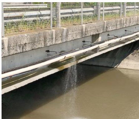
Perdita di acqua potabile dalla condotta dell'acquedotto sotto il ponte in località Desmontà (comune di Veronella) foto d'archivio (aprile 2018)
